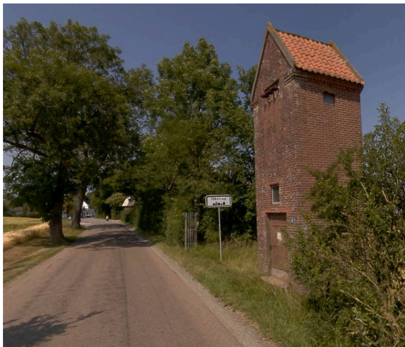
Billede 1: Transformertårn ved Løballevej.
