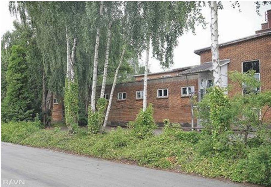
Figur 5: Foto af den sydligste del af hovedbygningen set fra Lido Allé. Her er det bagsiden af garager samt en række små vinduer til keglebanen.
