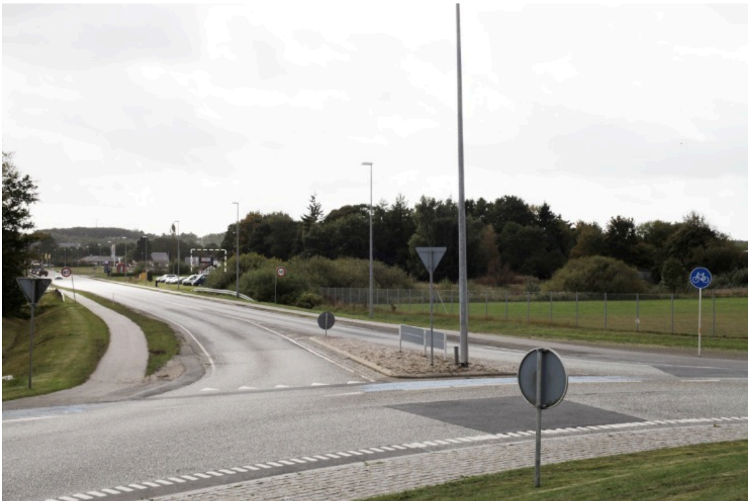
Figur 3: Den hvide stiplede linje er ca. placering af udvidelsen. Udvidelsen op til 15 meter, er ikke synligt fra rundkørslen.
