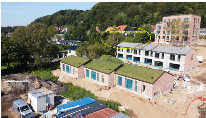
Figur 4: Boligområdet under opførelse uden altaner på etageboligerne. Foto viser højden på det eksisterende beplantningsbælte mellem de eksisterende boliger vest og den nye bebyggelse.
