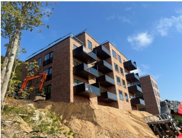
Figur 1: Etageboliger under opførelse set fra beplantningsbæltet mod vest. Altaner etableret efter bygherres ønske.
