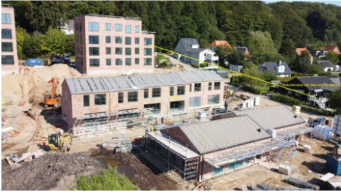
Figur 5: Boligområdet under opførelse uden altaner på etageboligerne. Fotos skal illustrere at terrassen på Kærvej 1 ikke kan ses fra etageboligerne.
