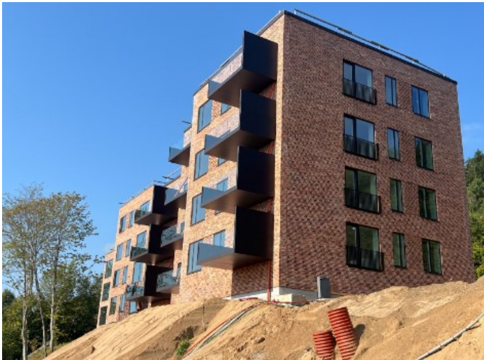
Figur 3: Etageboliger under opførelse. Forrest i billedet ses det midterste punkthus. I baggrunden ses beplantningsbæltet. Altaner etableret efter bygherres ønske.
