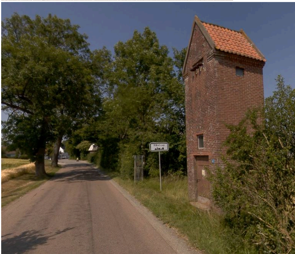
Figur 2. Transformatortårn på Industrivej 103 i Børkop. Håstrup.
