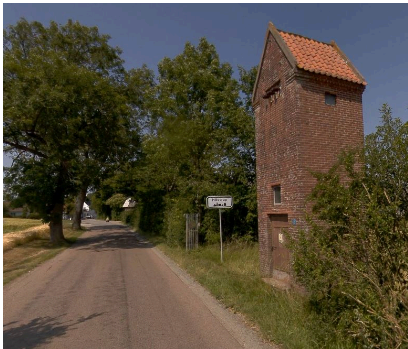
Billede 1: Transformertårn ved Løballevej.
